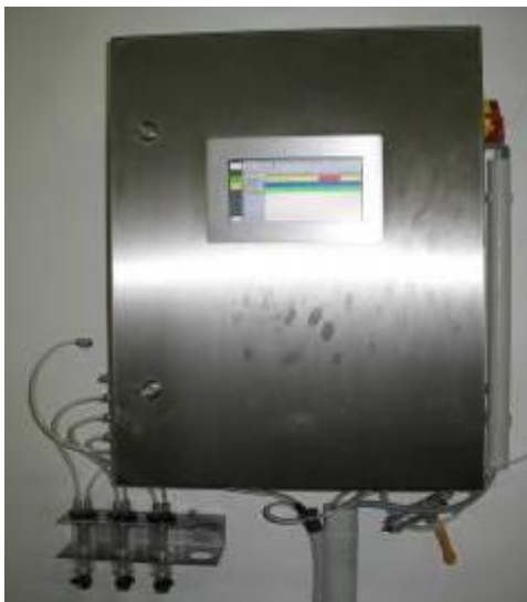
Misuratore qualità del biogas Raffreddamento ed essiccazione
